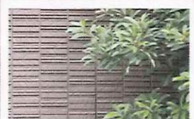
外壁工事全般
