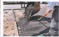
外構工事・地盤調査 etc
